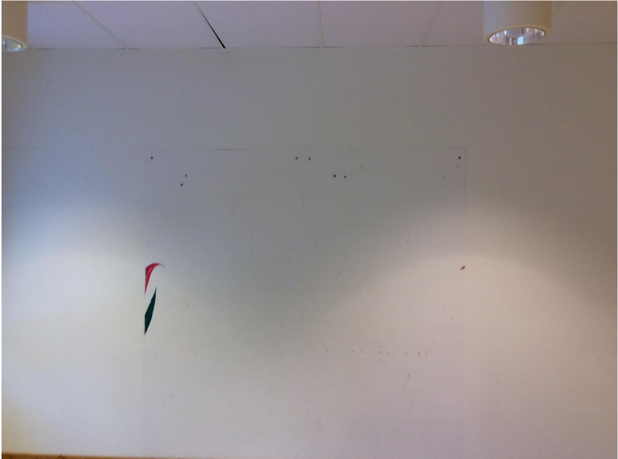
På den tomma väggen syns skruvhålen efter borttagna garderober.
